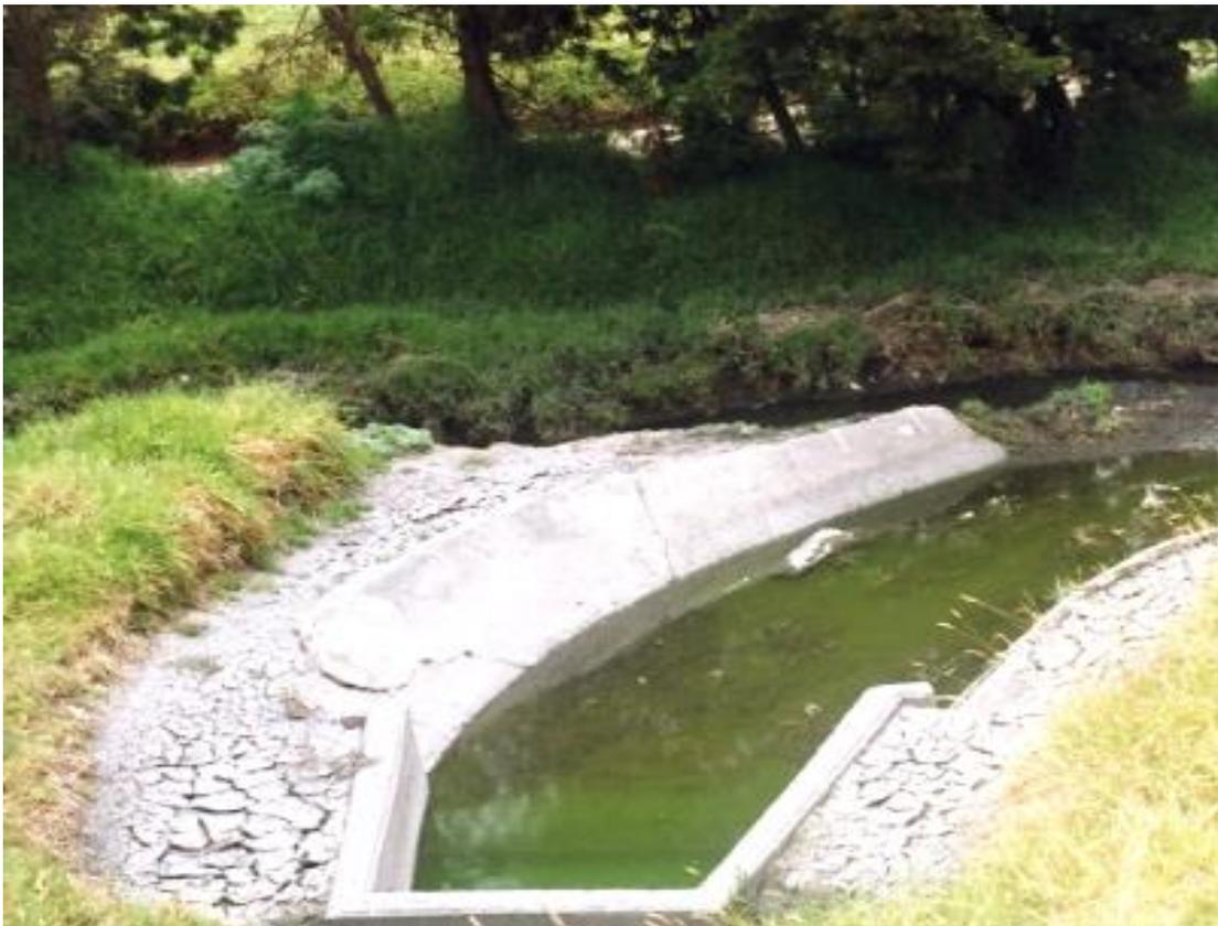
Las lagunas aireadas son alternativas que se ha utilizado comúnmente para mejorar la capacidad de tratamiento de las lagunas de oxidación, y consiste en implementar sistemas de aireación que oxigenan y mezcla el agua, con lo cual se logra la transferencia de oxígeno necesaria para remover nitrógeno y  $DBO_5$  y activar el mecanismo de stripping que remueve nitrógeno amoniacal. Existen dos clases de lagunas:
